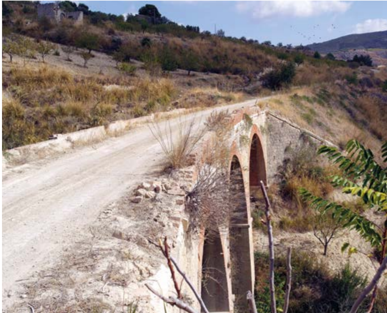
Viadotto al km 14+236
