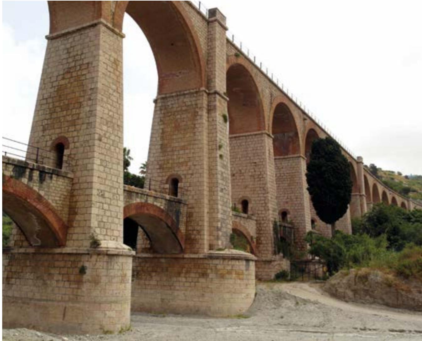
Viadotto al km 215+114
