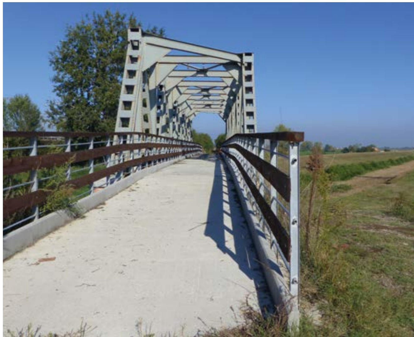
Ponte in acciaio ristrutturato sul Torrente Lavino
