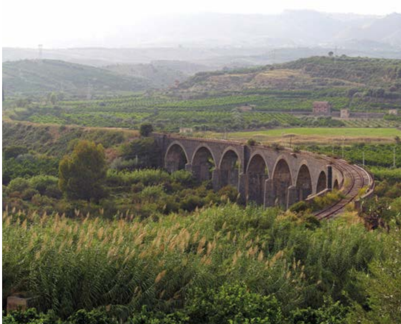
Viadotto al km 21+924
