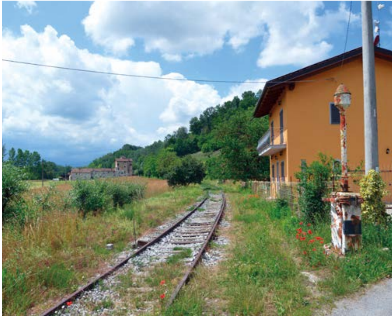
Ex casello in località Bivio Ellero
