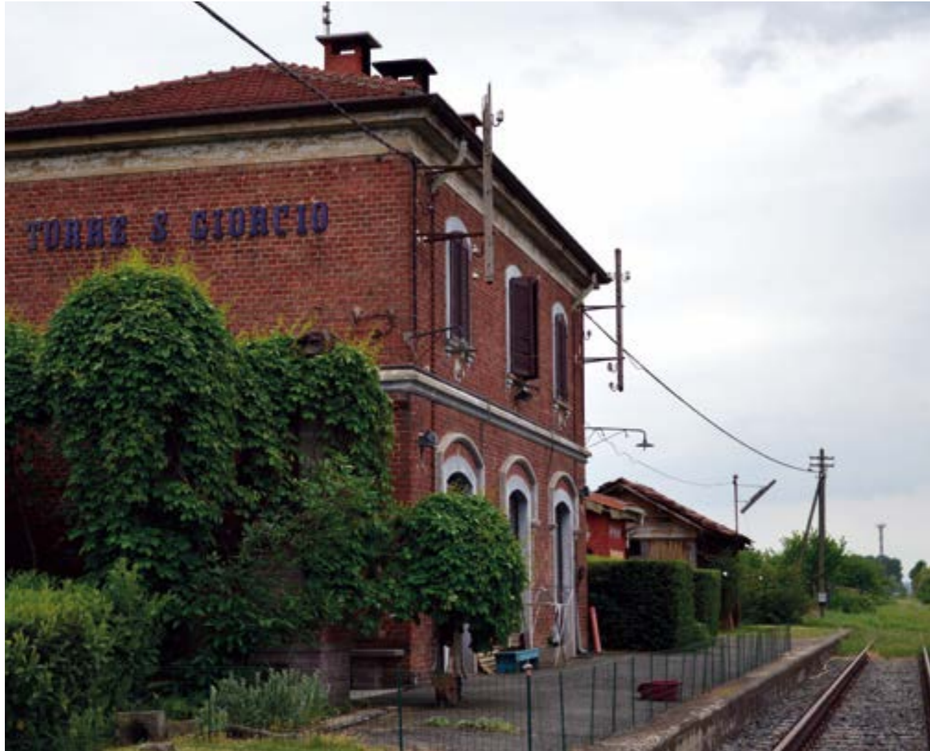
Stazione di Torre S. Giorgio
