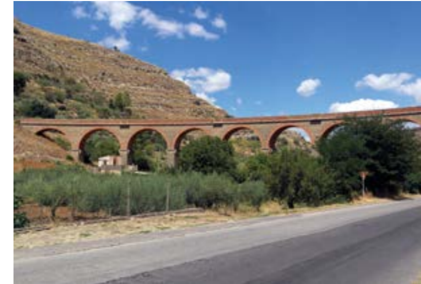
Viadotto al km 11+296
