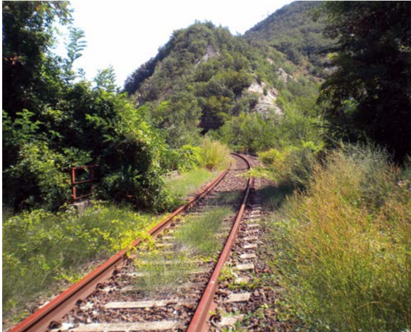
Tratto dismesso tra Citerna e Solignano al km 33+160
