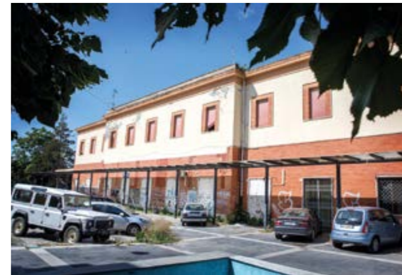
Piazzale esterno Stazione di Catanzaro Sala
