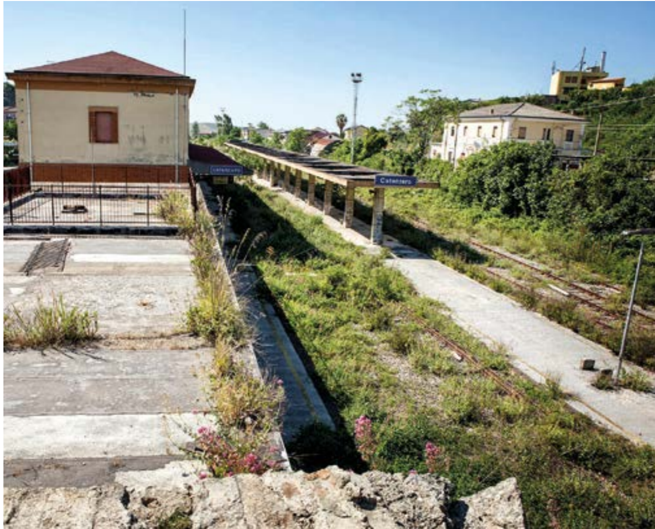
Stazione di Catanzaro Sala vista laterale
