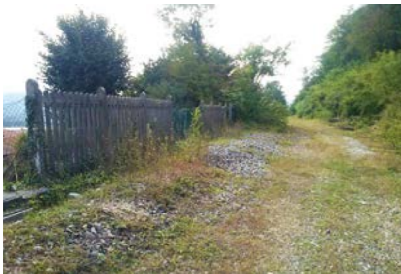
Tipica recinzione ferroviaria
