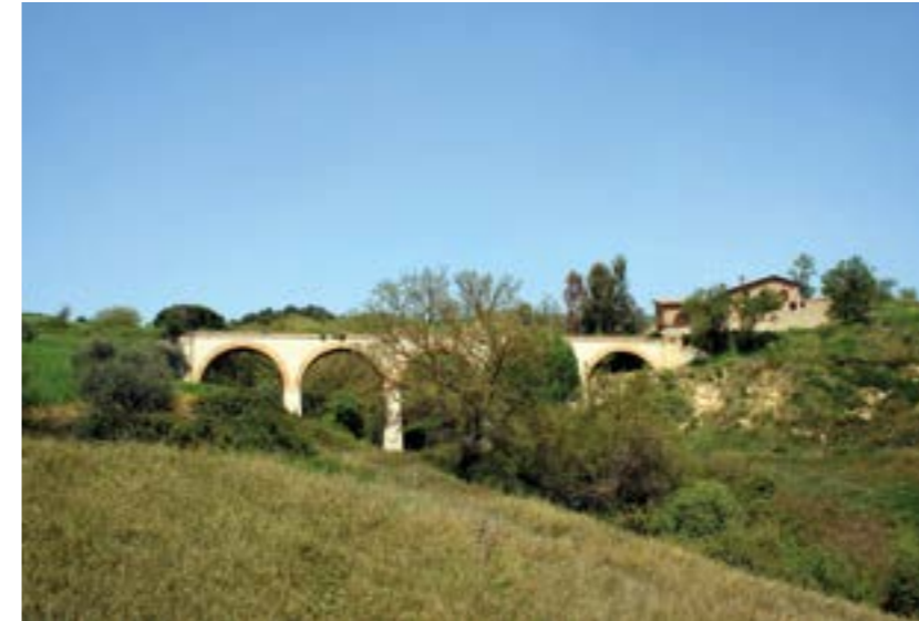
Viadotto al km 5+735
