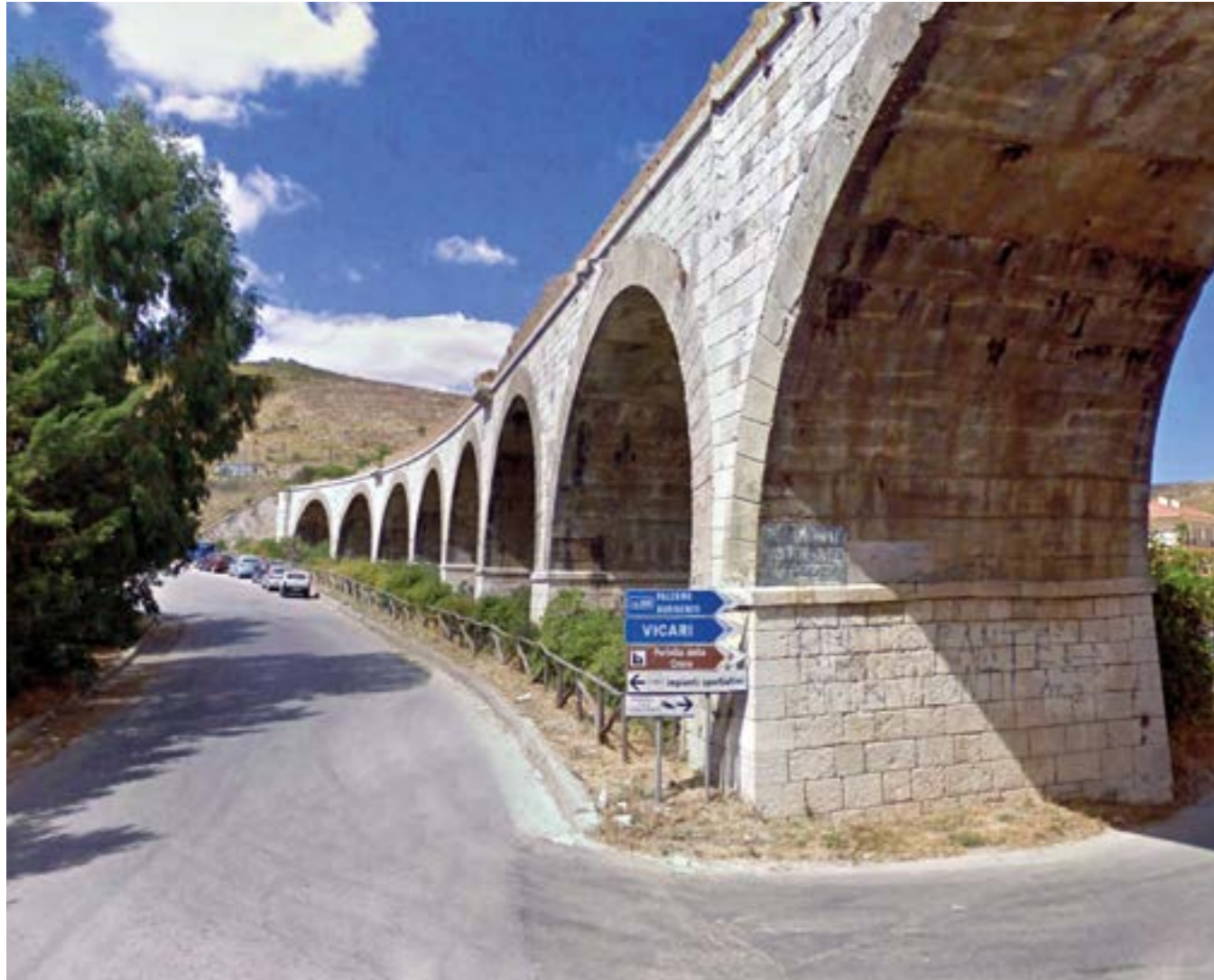
Viadotto al km 3+747
