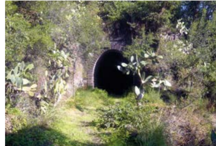
Galleria al km 257+937
