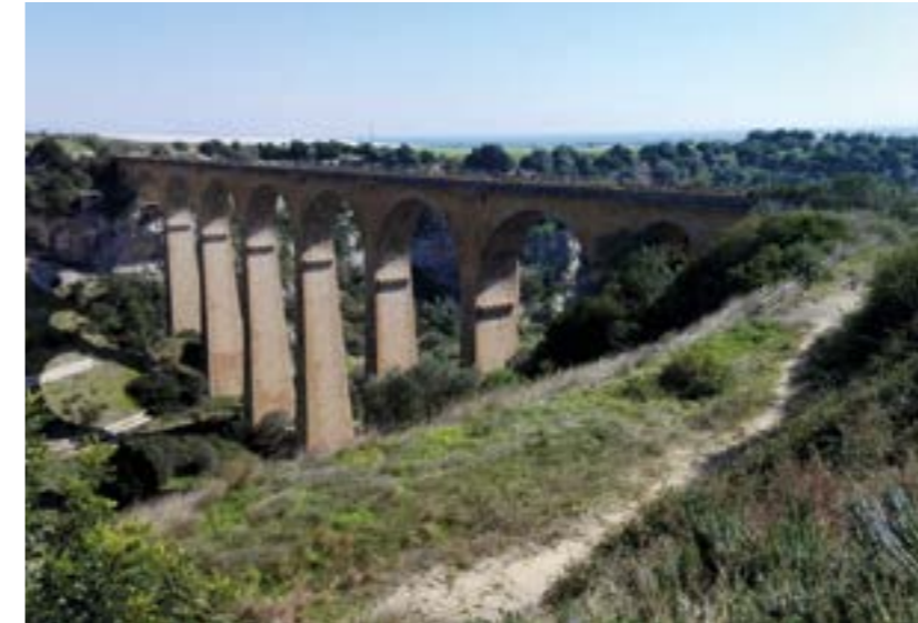
Viadotto sulla Gravina di Castellaneta
