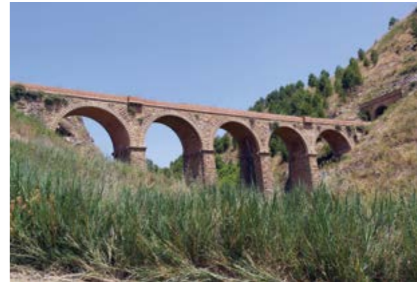
Viadotto al km 19+967
