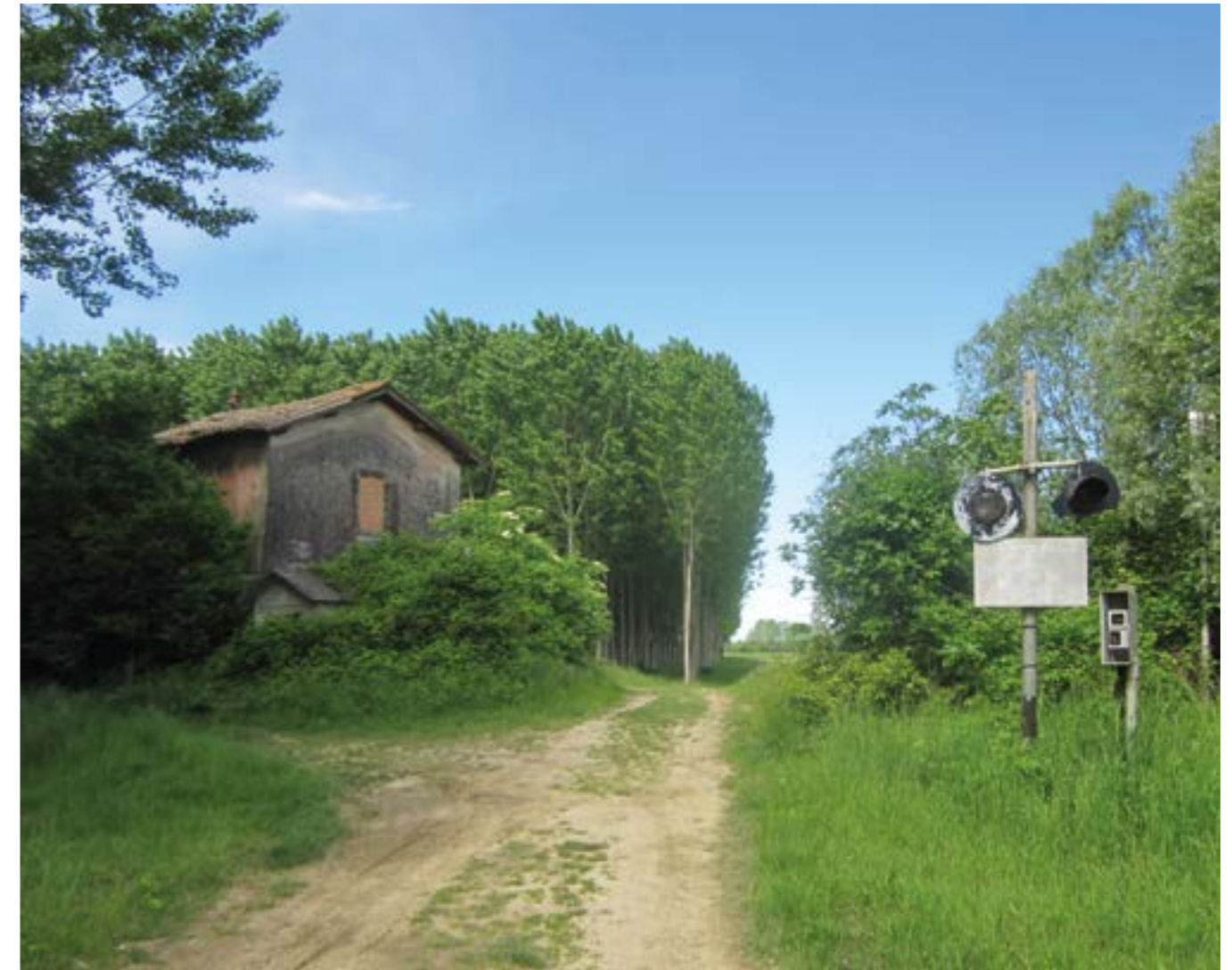
Casello al km 25+556
