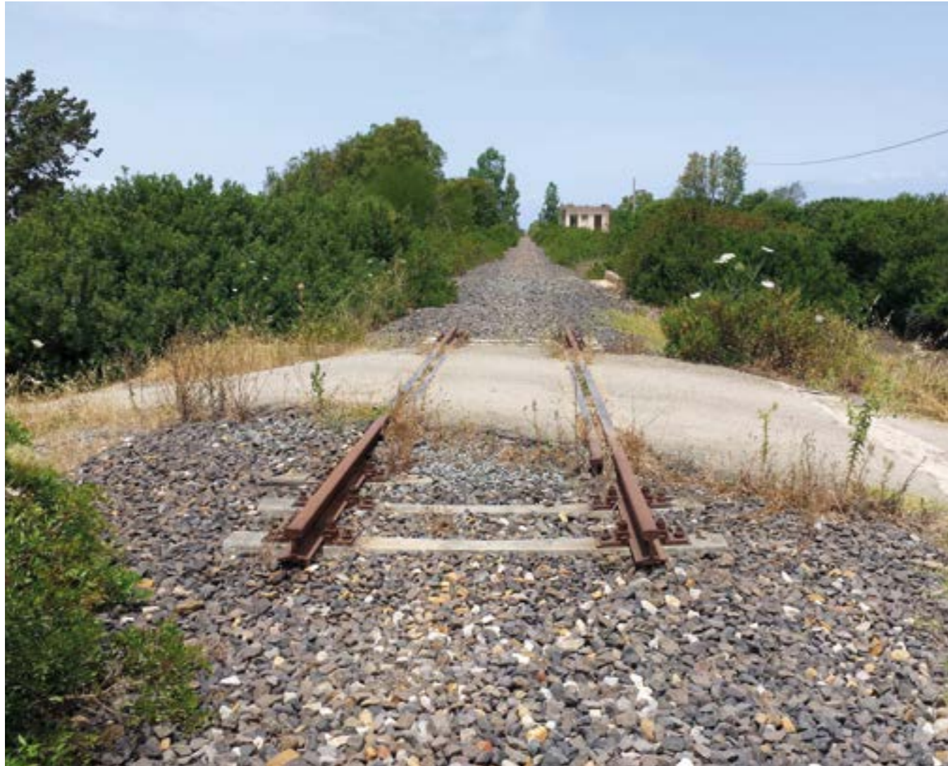
Sedime con presenza di binari
