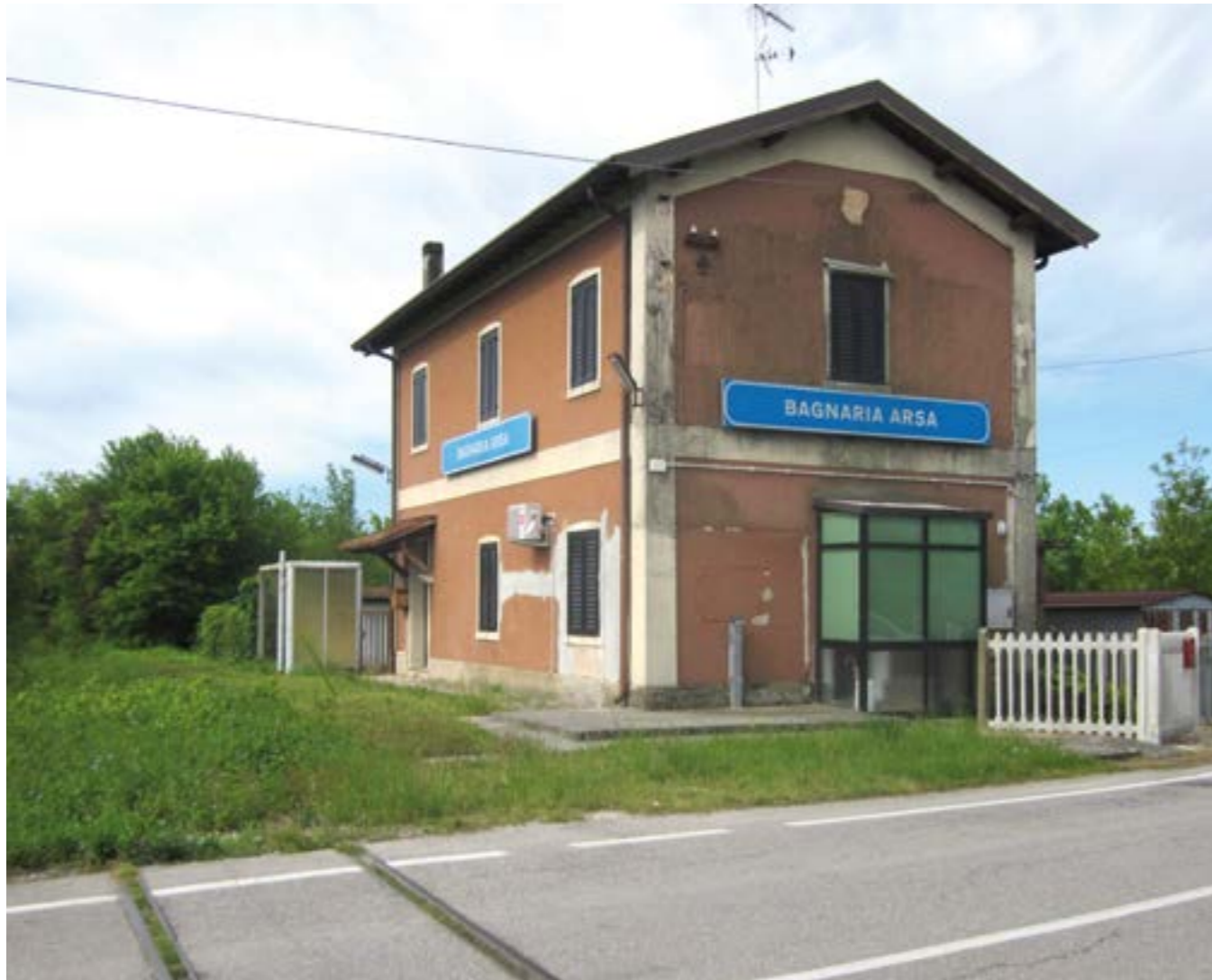
Stazione di Bagnaria Arsa
