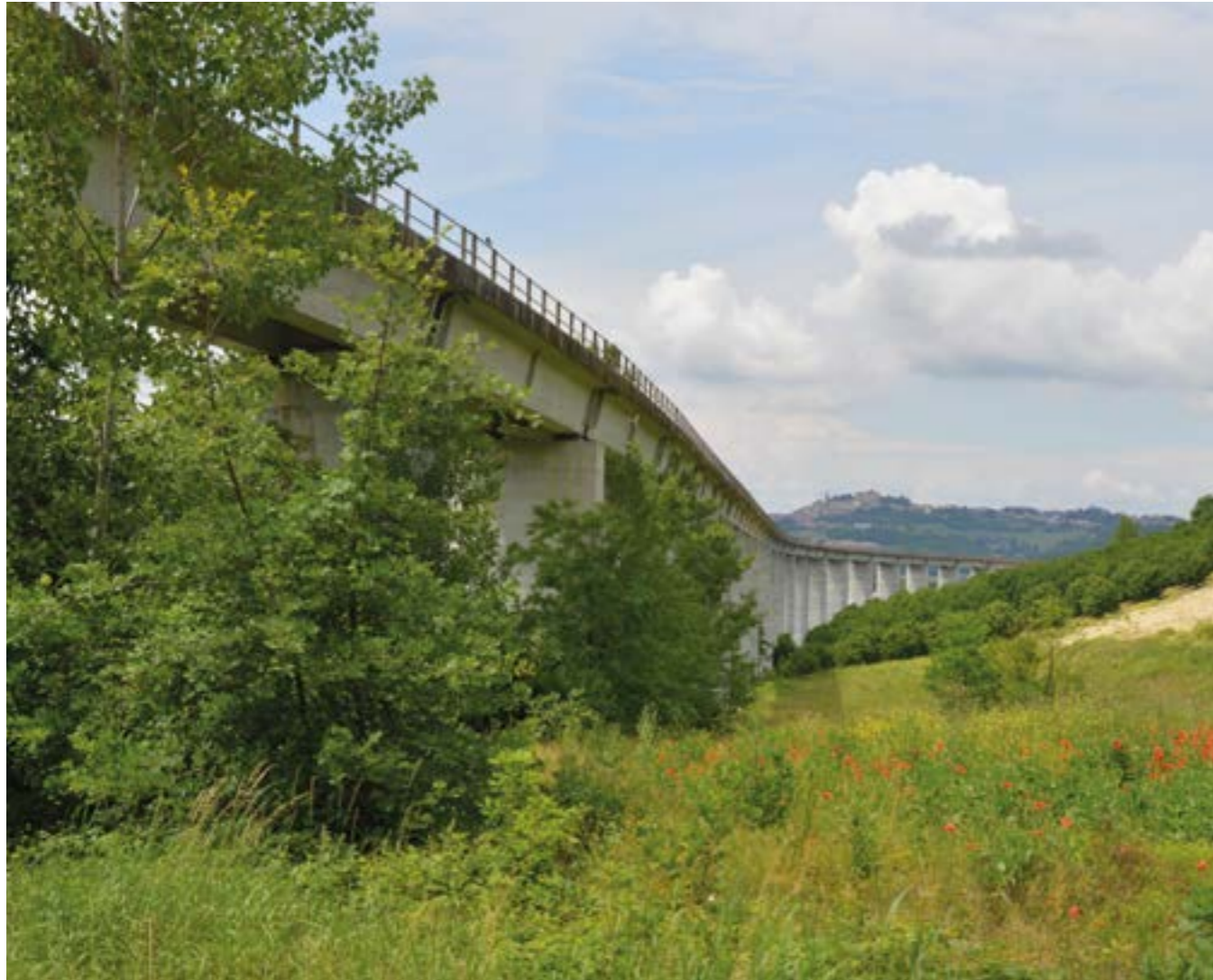
Viadotto a Castagnola delle Lanze
