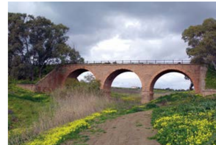
Viadotto al km 19+404
