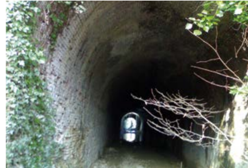
Galleria artificiale al km 38+455
