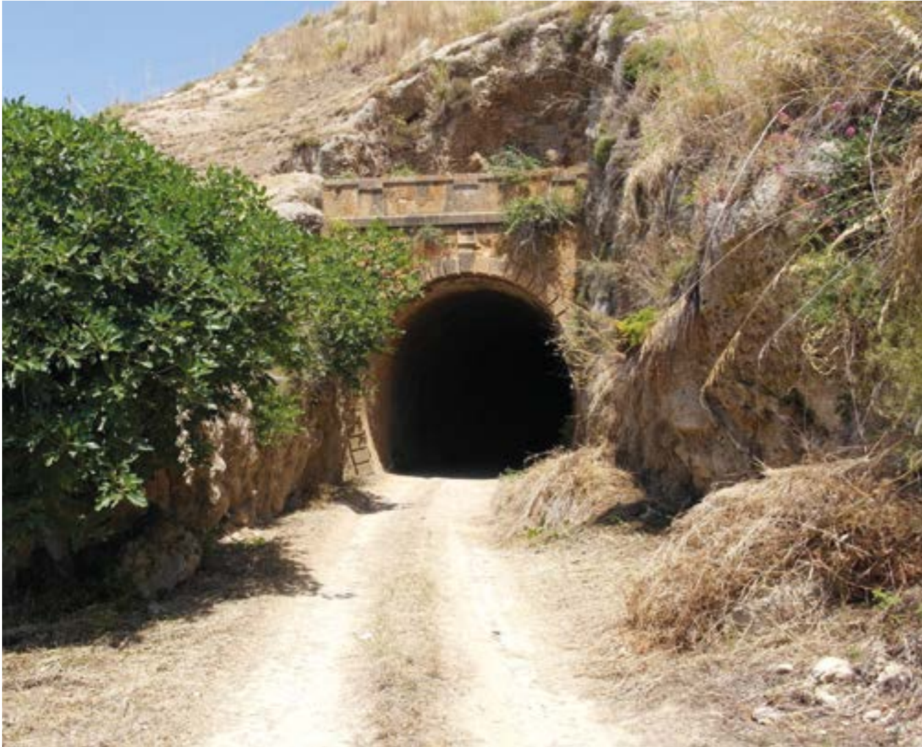
Galleria Mazzola km 20+326
