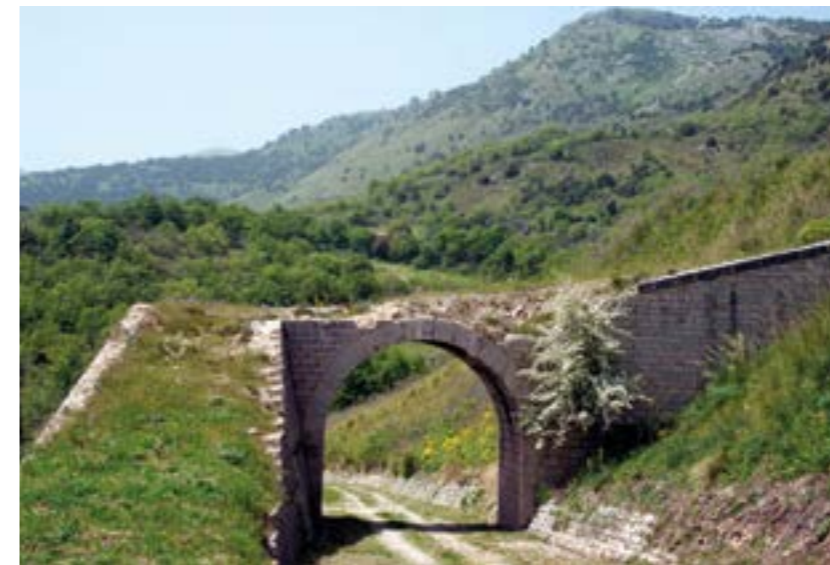
Cavalcavia al km 32+661
