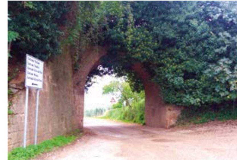
Arco in muratura lungo il sedime
