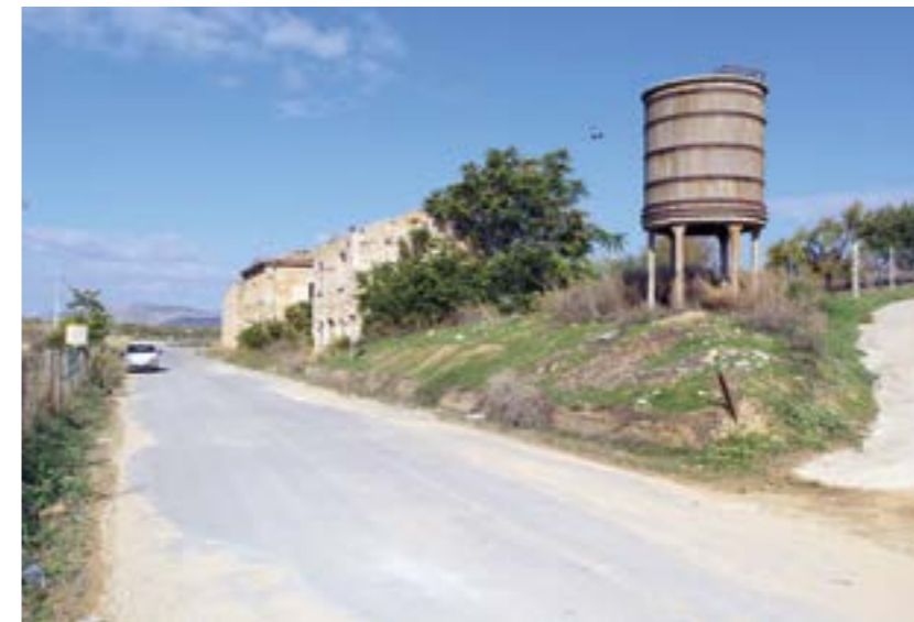
Serbatoio idrico nella stazione di Margonia
