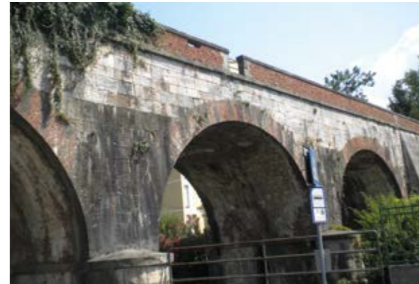
Ponte in muratura sul torrente Bertino km 175+146
