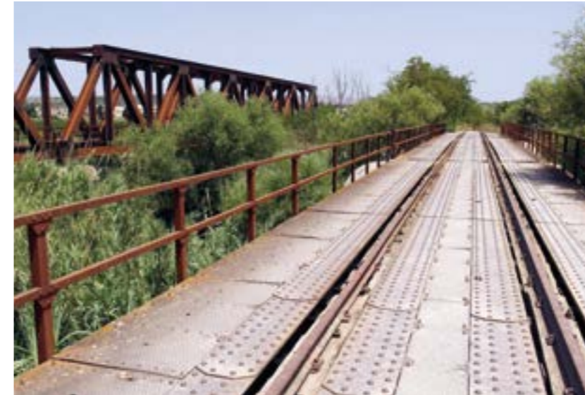
Ponte in ferro km 10+486
