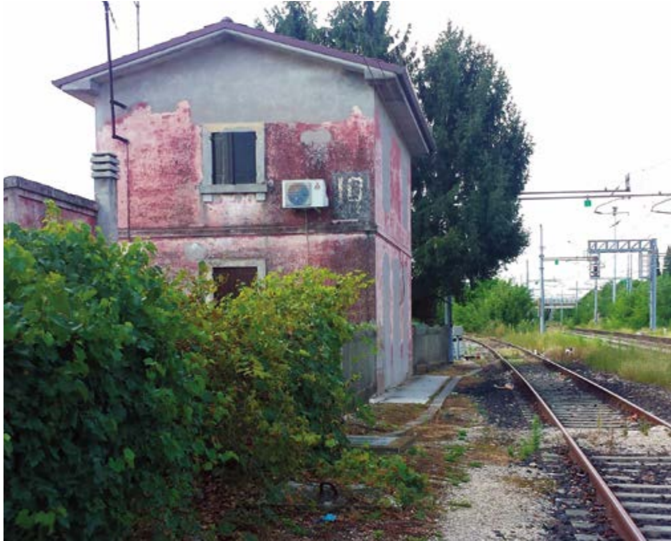
Casello nei pressi della stazione di Dossobuono
