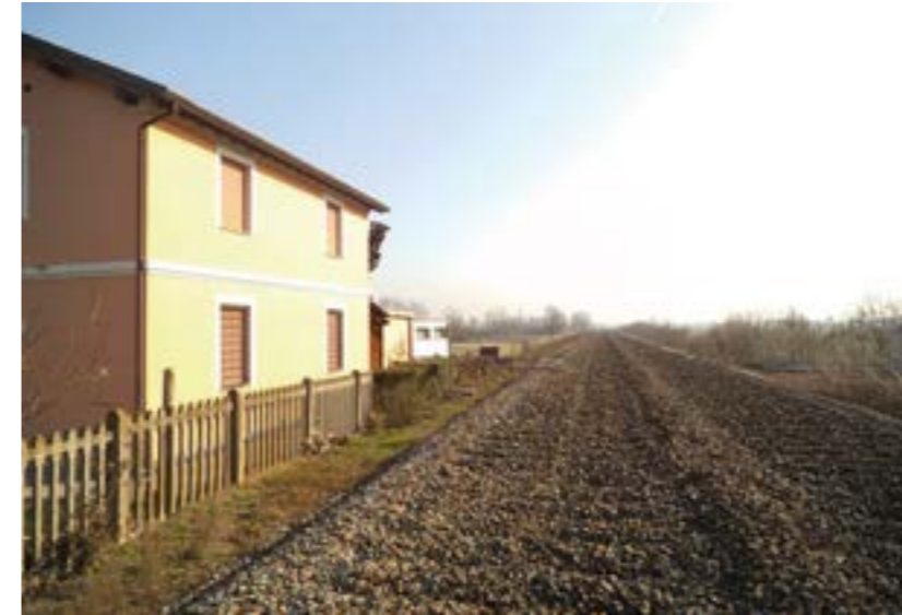
CC collocata lungo il tracciato
