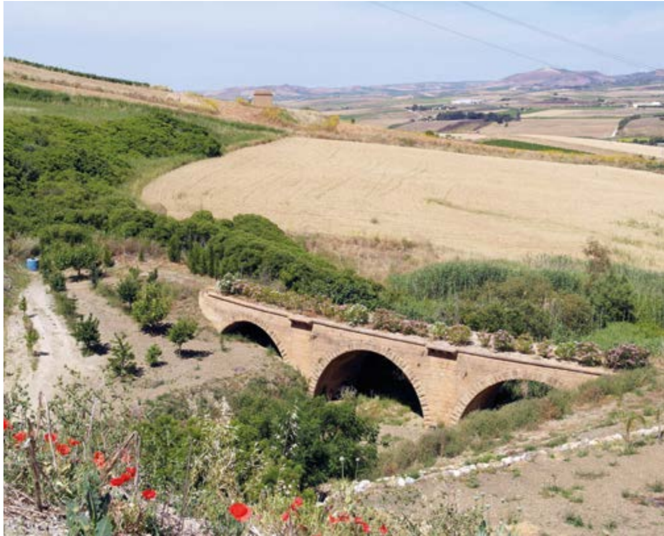
Viadotto al km 7+938
